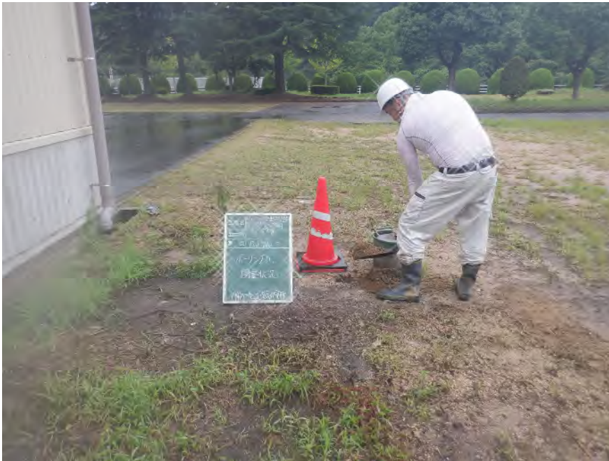
ボーリング孔閉塞状況
