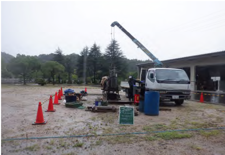
搬入・搬出状況 (小型移動式クレーン)
